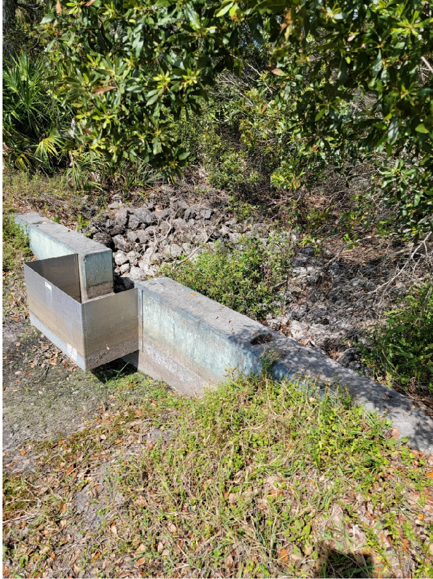
Control Structure - CS-1
