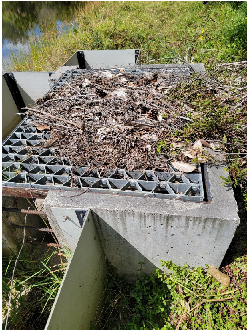
Control Structure - CS-3
