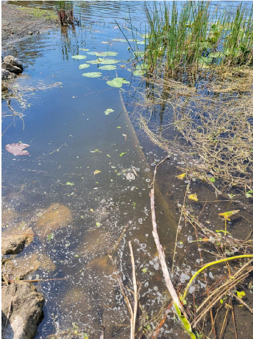
Control Structure - CS-10
