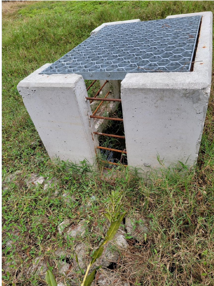
Control Structure - CS-31
