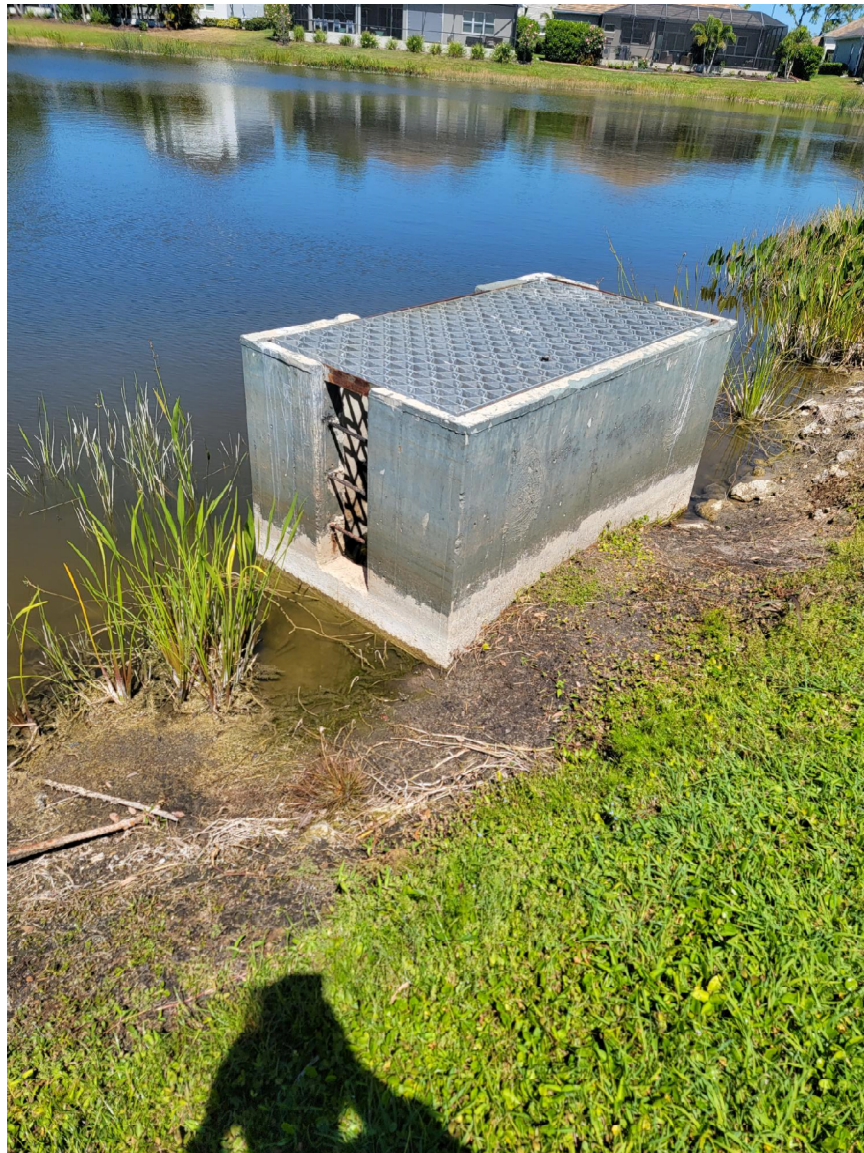
Control Structure - CS-24
