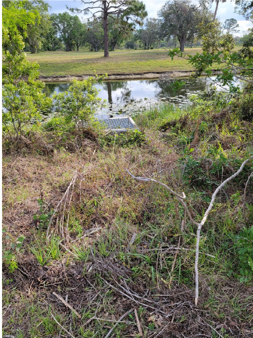
Control Structure - CS-49
