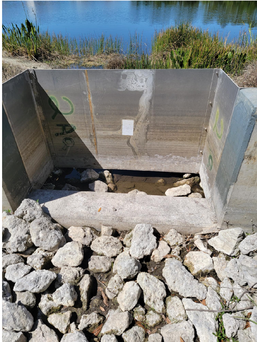
Control Structure - CS-23
