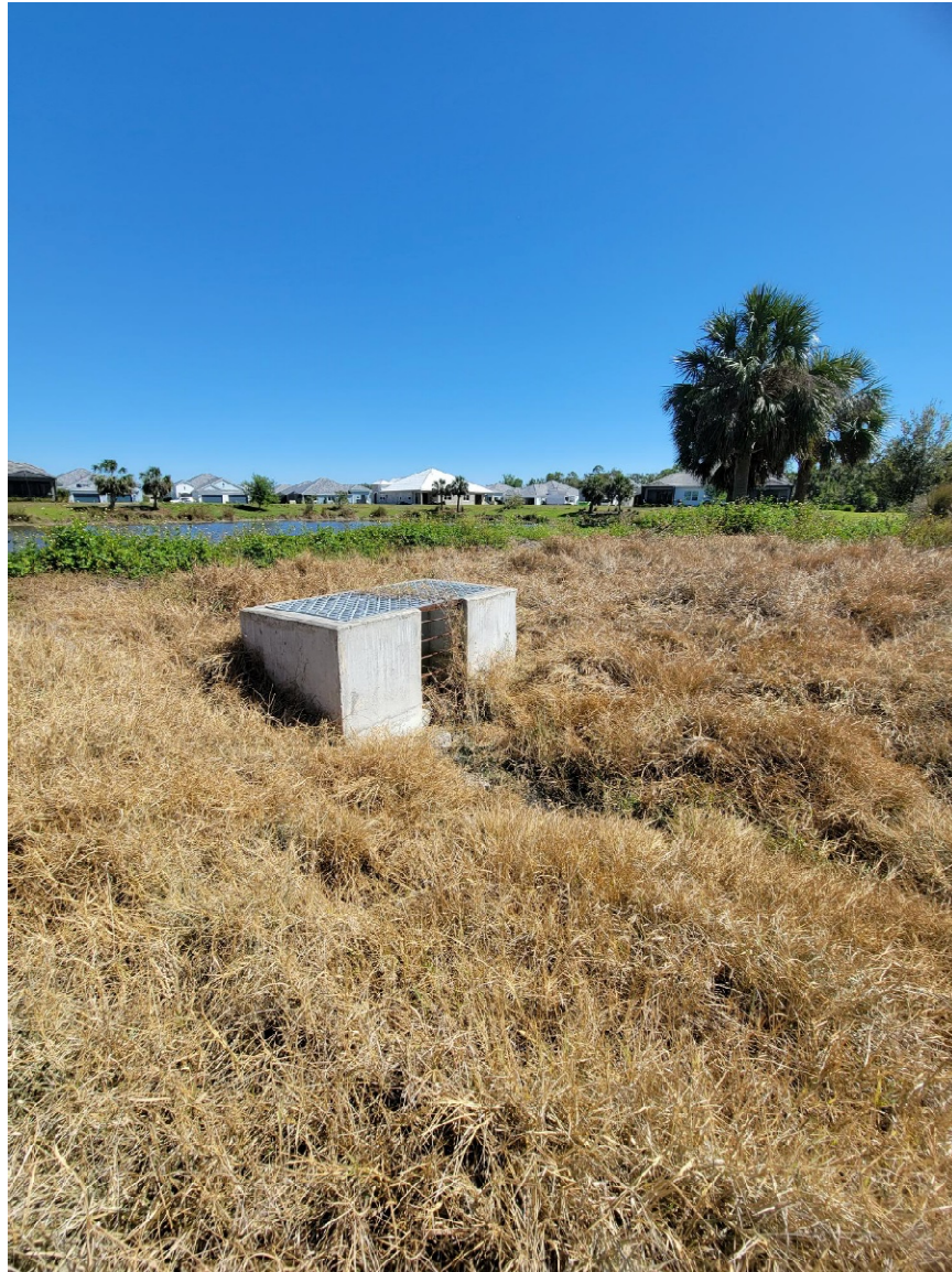
Control Structure - CS-35
