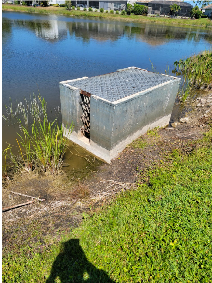
Control Structure - CS-24
