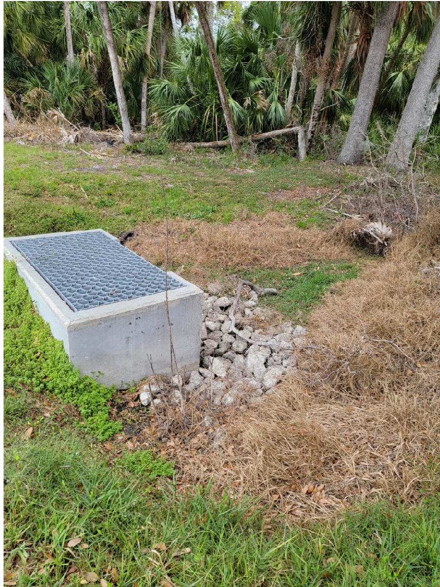
Control Structure - CS-32
