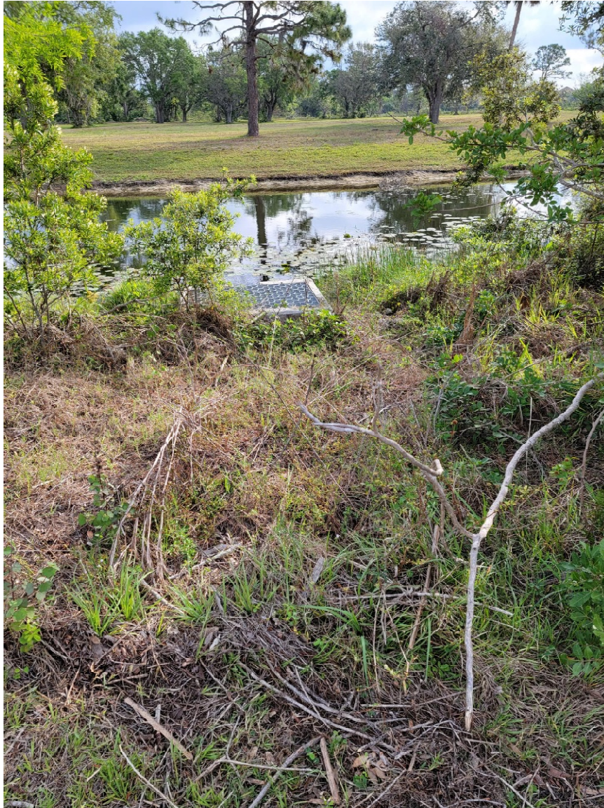
Control Structure - CS-49
