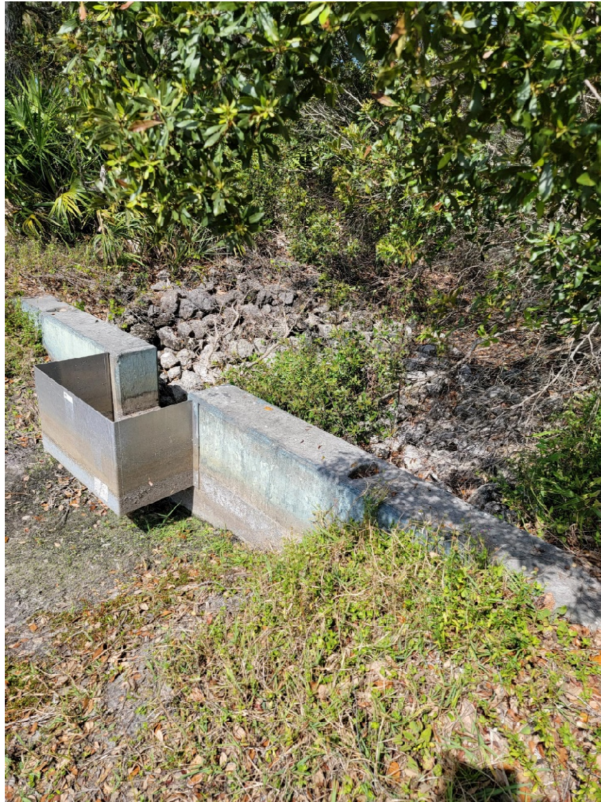
Control Structure - CS-1
