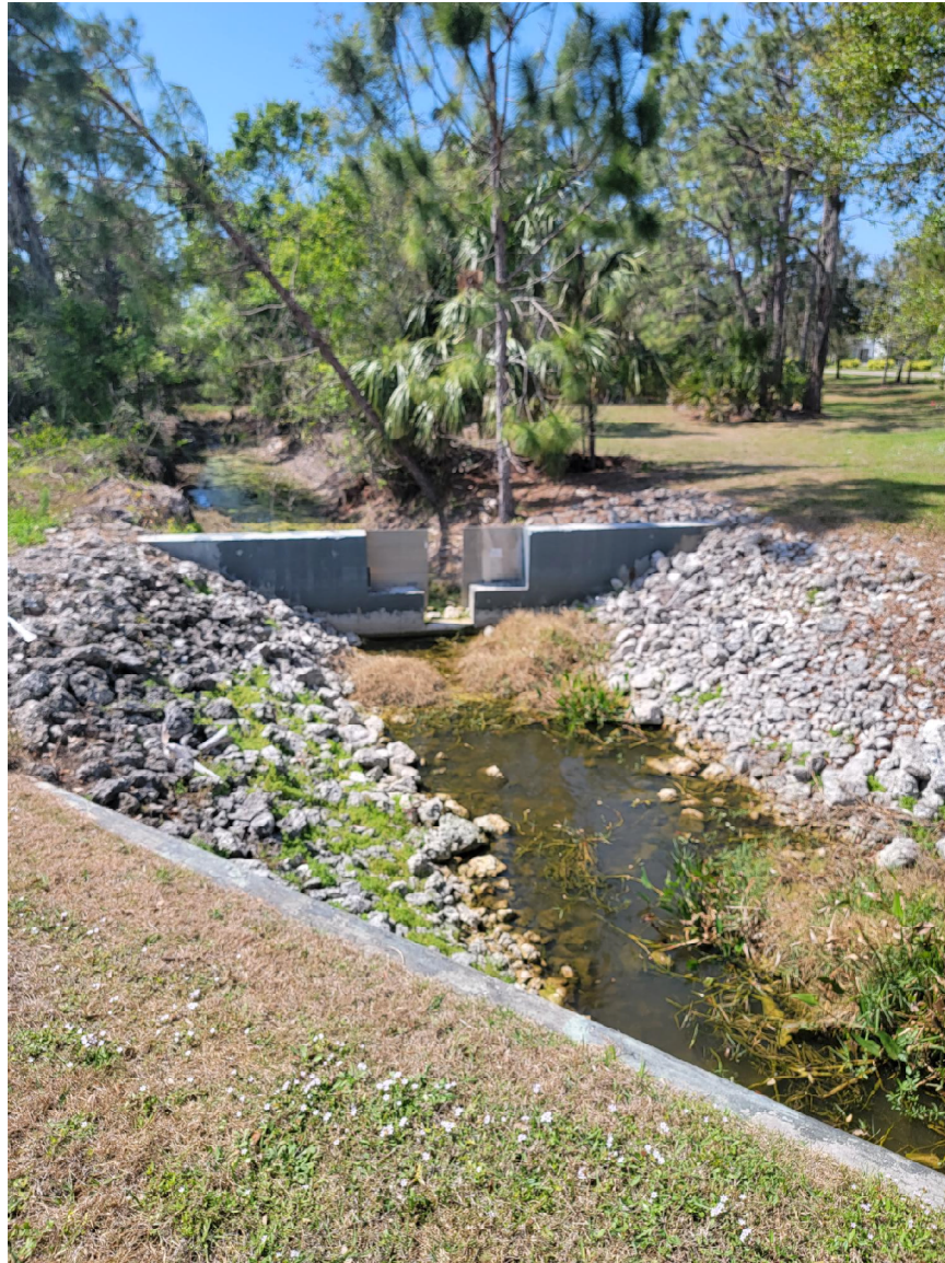
Control Structure - CS-48
