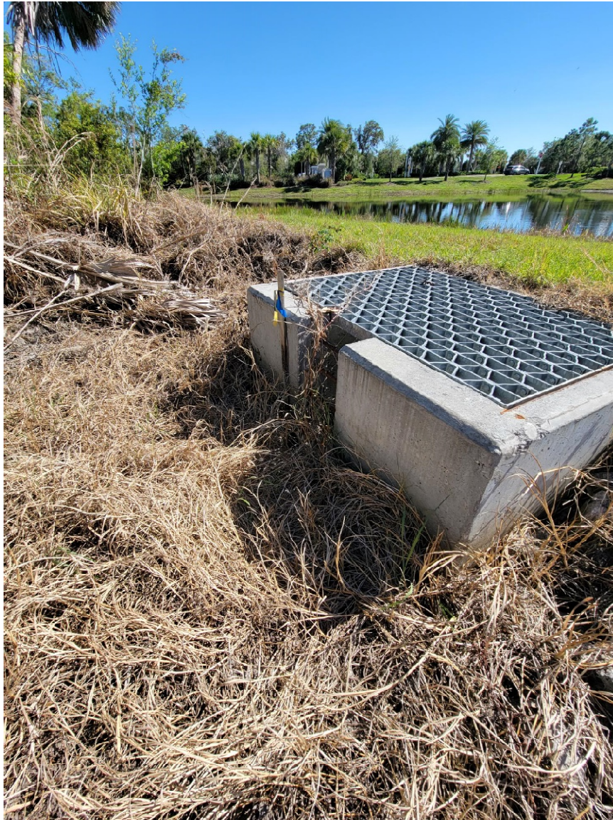
Control Structure - CS-41
