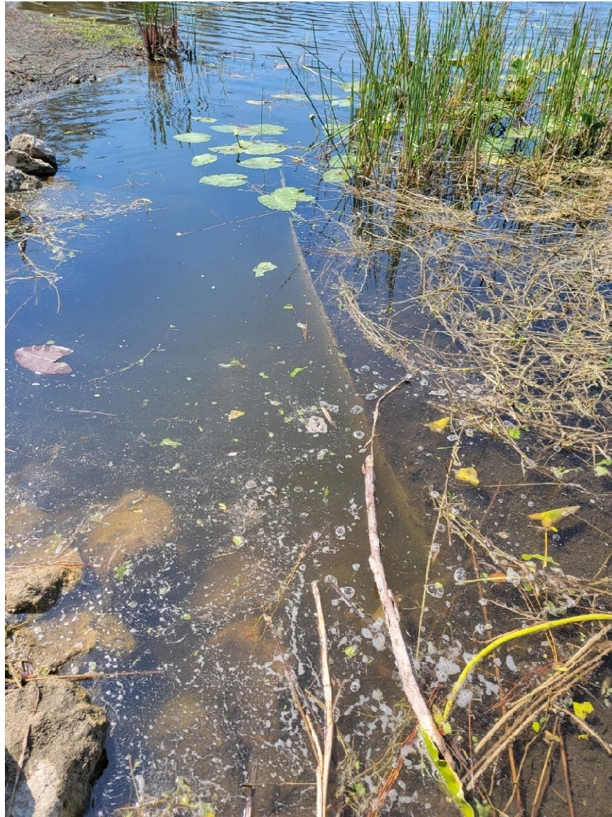
Control Structure - CS-10
