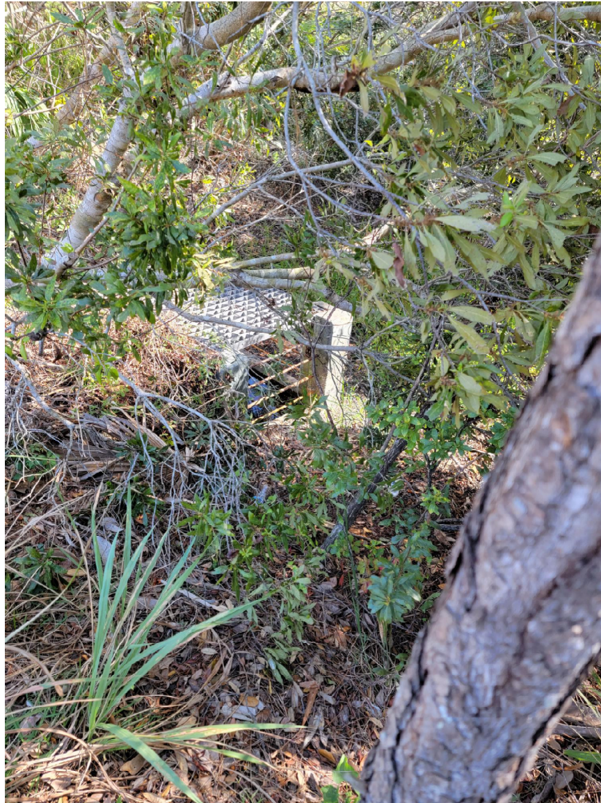
Control Structure - CS-X2A
