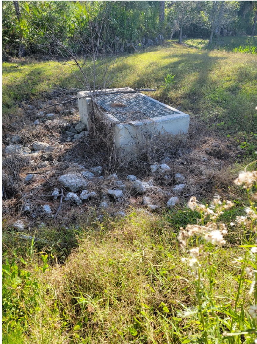
Control Structure - CS-47
